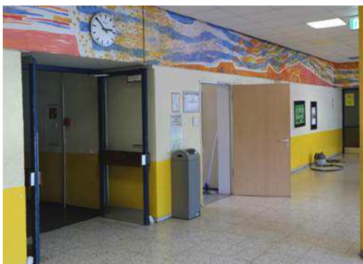
Wand gegenüber vom Haupteingang tb/1621
